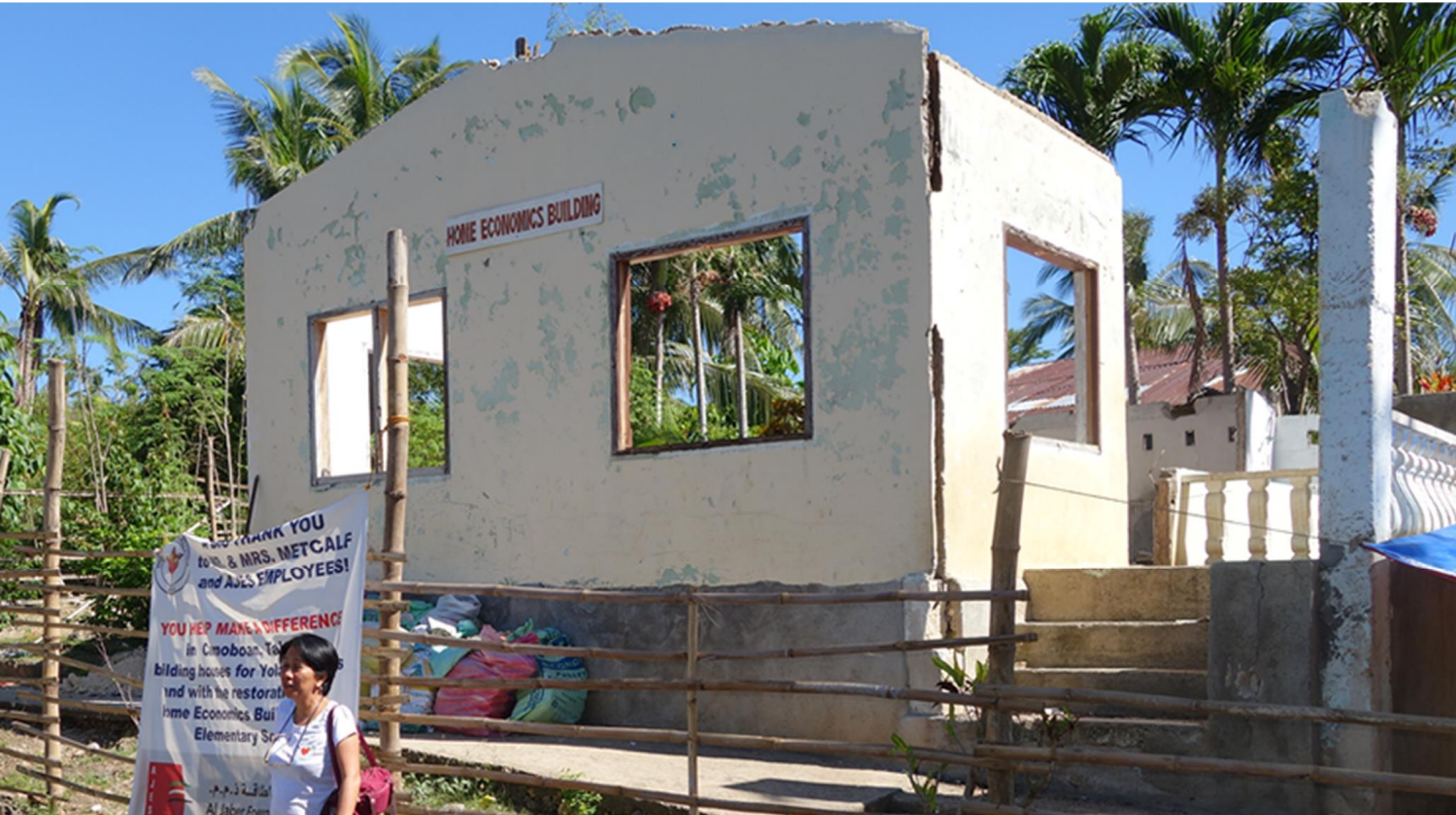
Dieses Schulhaus in Tagobon (Philippinen) wird mit Ihrer Hilfe wieder aufgebaut.
